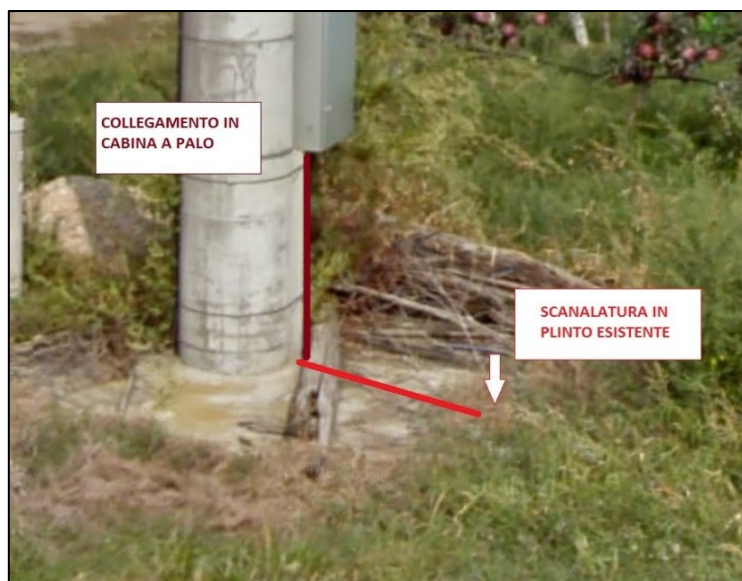
Particolare dell'intervento per la posa del cavidotto su plinto e-distribuzione
